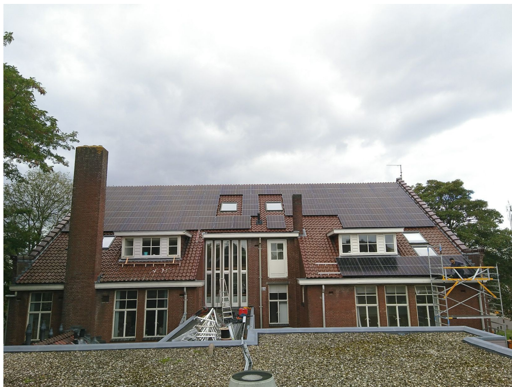
Zonnepanelen op het dak van gebouw D
